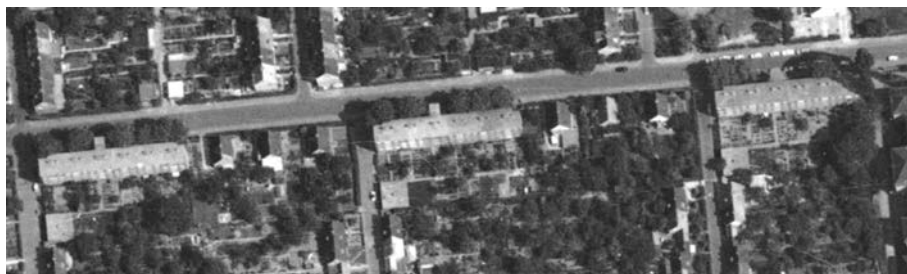
Abb. 6: Dessau. Luftbild 1979. Drei der insgesamt fünf Laubenganghäuser in der Peterholzstraße. Das Untersuchungsobjekt (Nr. 48) ist das mittlere Gebäude. Erkennbar sind u. a. die Mietergärten und das Spielplatzareal mit Sandkasten im Südosten des Grundstücks (Foto: © GeoBasis-DE/LVermGeo LSA, 2018, C24-8002346).
