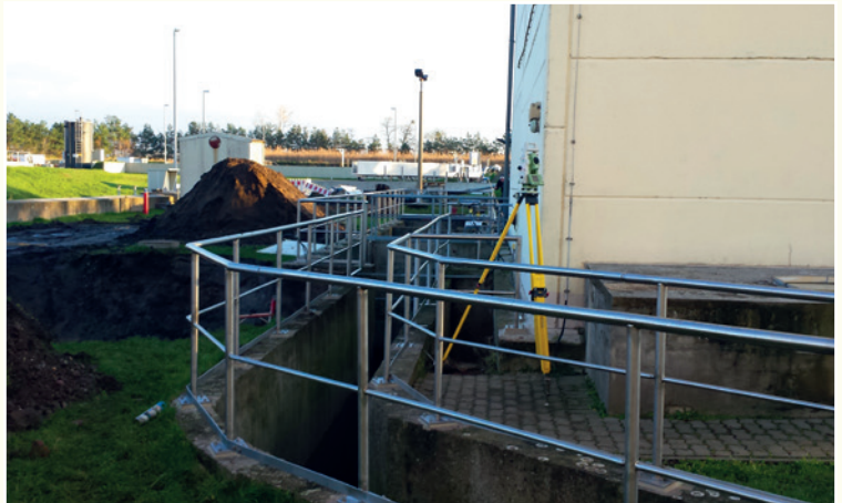
Abb. 1: Vermessung bei der Errichtung einer Kläranlage
